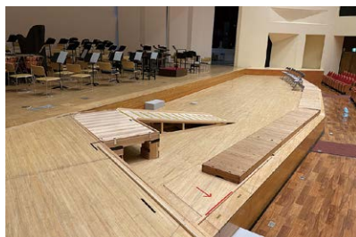
みんなのスマイル・コンサートのためにつくられた車椅子用スロープ
